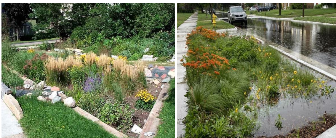
Slika 65. Primjer kišnog vrta uz prometnice
